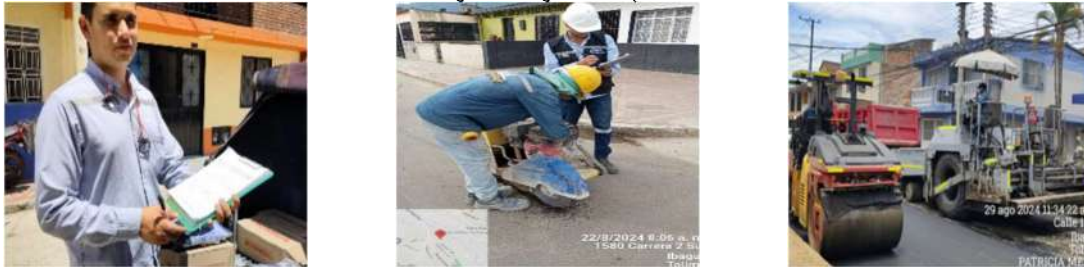
Ilustración 15: Registro fotografico Inspecciones de obra
