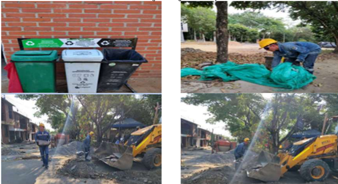
Ilustración 14: Registro fotográfico orden y aseo.
